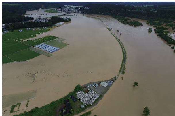
UAV画像（大蔵村白須賀越水地点）
