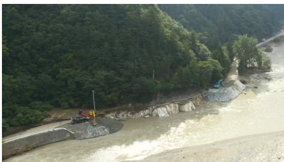
岩泉町乙茂上地区の国道455号応急復旧状況
